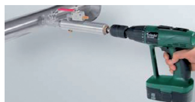
Anbohren unter Druck
